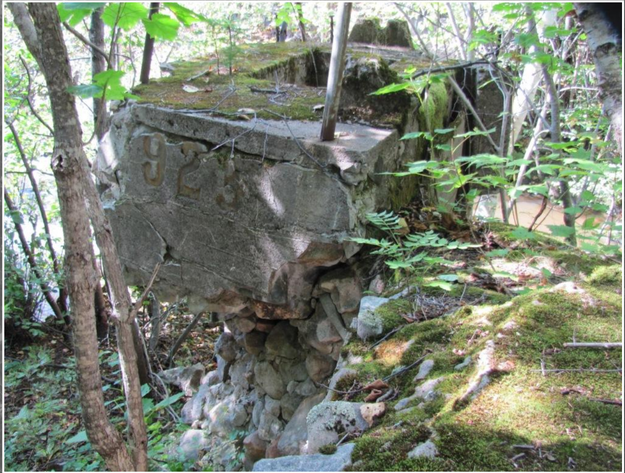
Vestiges d'une restauration du barrage (1923)
