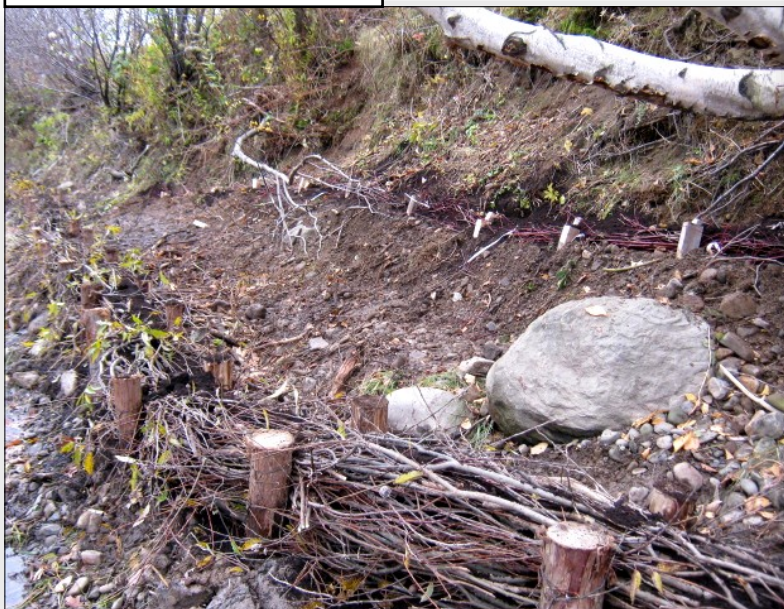
Aménagement de génie végétal
