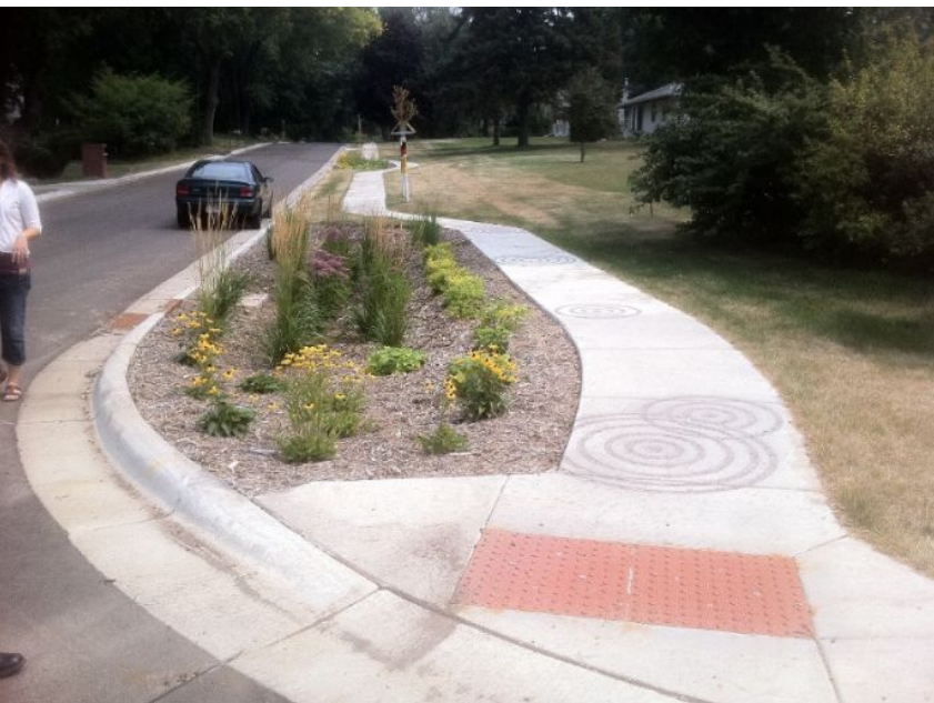
Aménagements de gestion des eaux pluviales. Source: Lasalle | NHC
