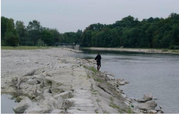
Berges de béton en pente – Avant
