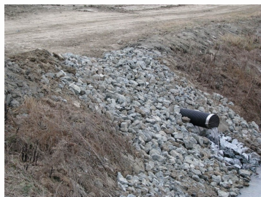
Chute d'eau enrochée
