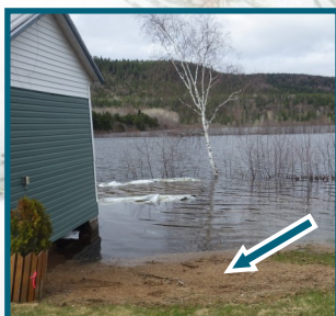
Ligne de débris laissée par la rivière Croche
