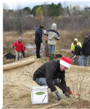
Installation d'un tapis de paille en bordure d'un milieu humide.
