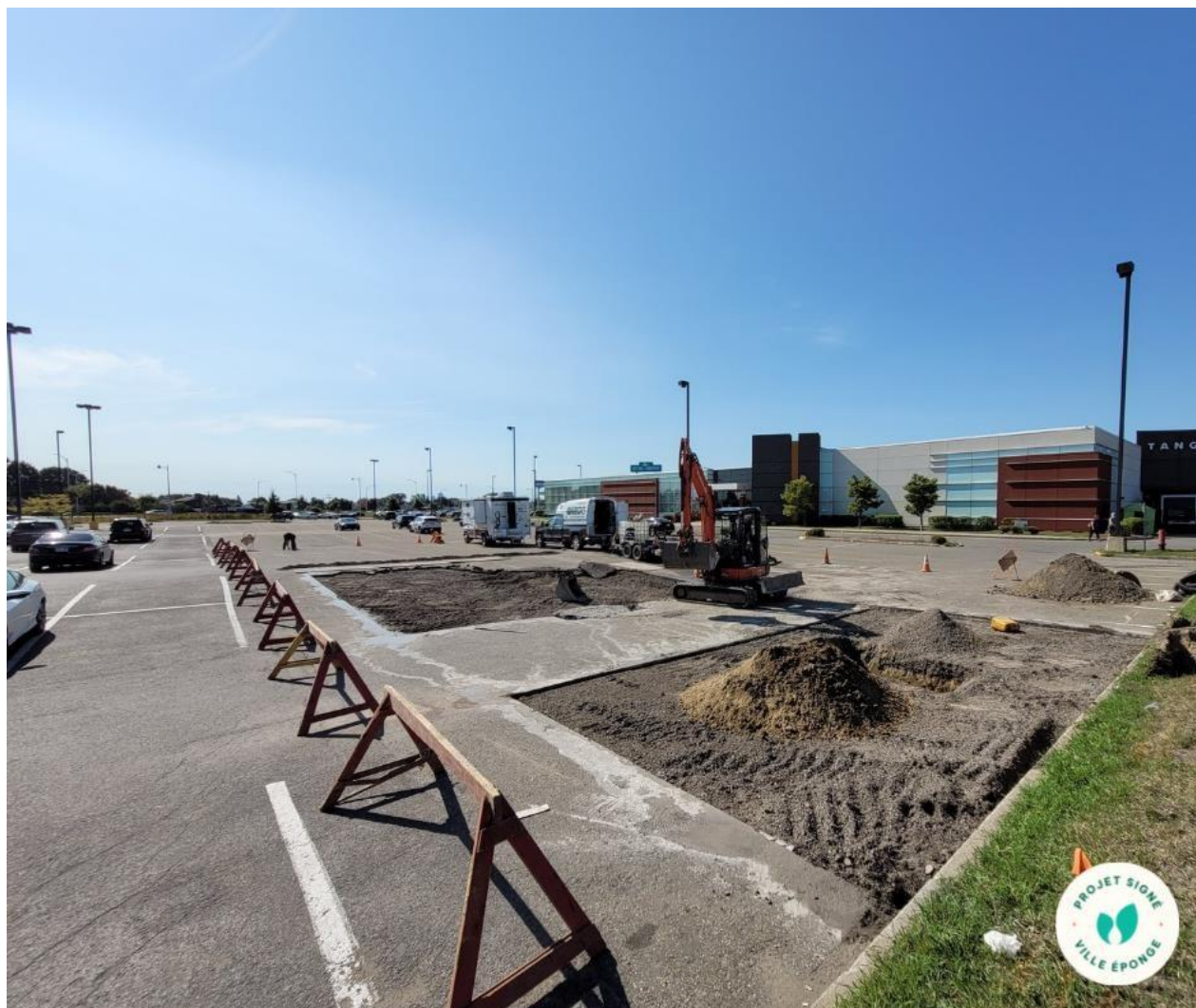
Crédit photo : Organisme des bassins versants de la Capitale—Début des travaux
