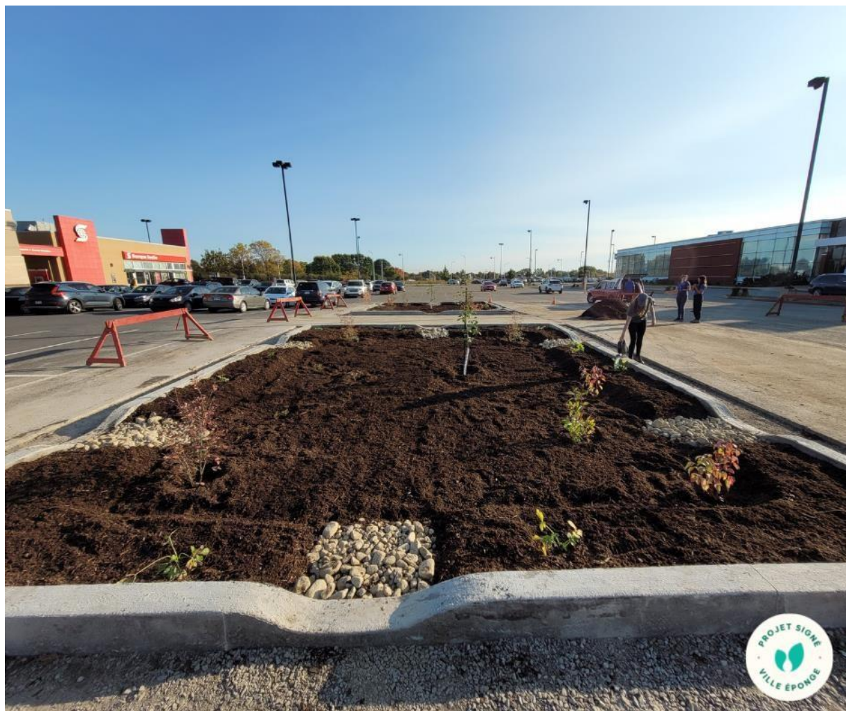
Crédit photo : Organisme des bassins versants de la Capitale— Fin des travaux
