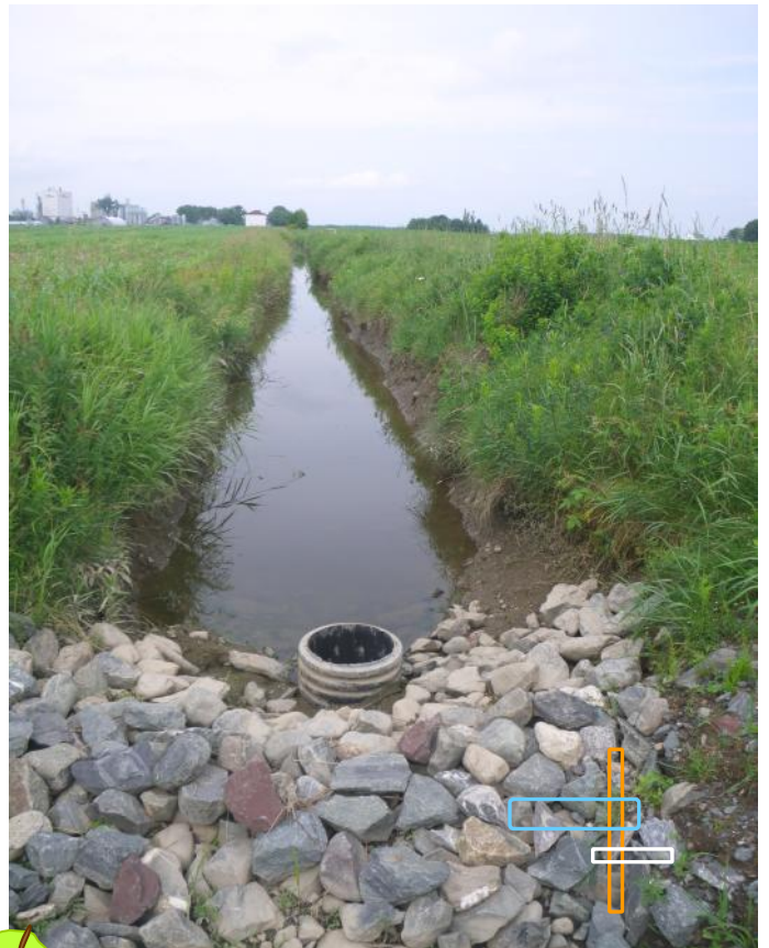
Fig.5. Fossé-avaloir aménagé à Saint-Isidore.
