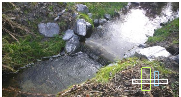
Fig.1. Seuil-frayère aménagé dans un tributaire de la Décharge à St-Isidore.
