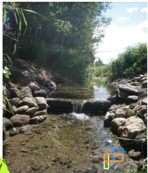
Sur la photo : seuil piscicoles (CBE 2010)
