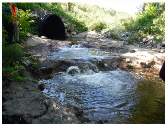
Entente 45. Aménagement de seuils et bassins dans le cours d'eau Laroche à Warwick pour le passage de l'omble de fontaine.
