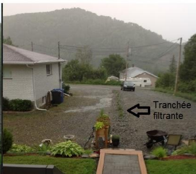
Tranchée filtrante à Matapédia Source: OBVMR
