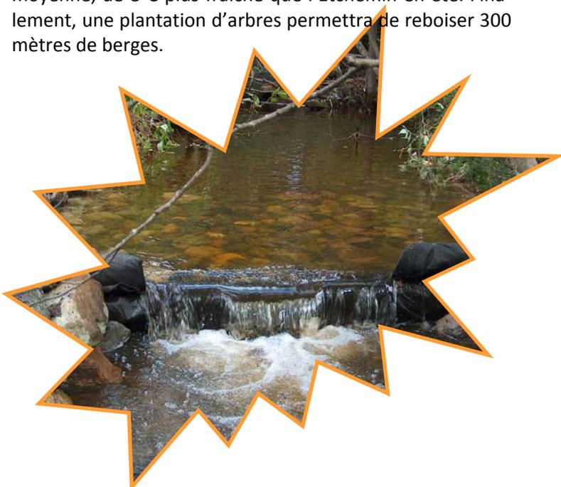
Photo 1. L'un des 3 seuils en bois construit manuellement sur le ruisseau Lapierre.
