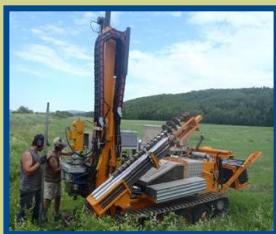
Forage à l'été 2013, PACES
