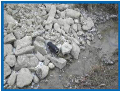
Protection de sortie de drain
