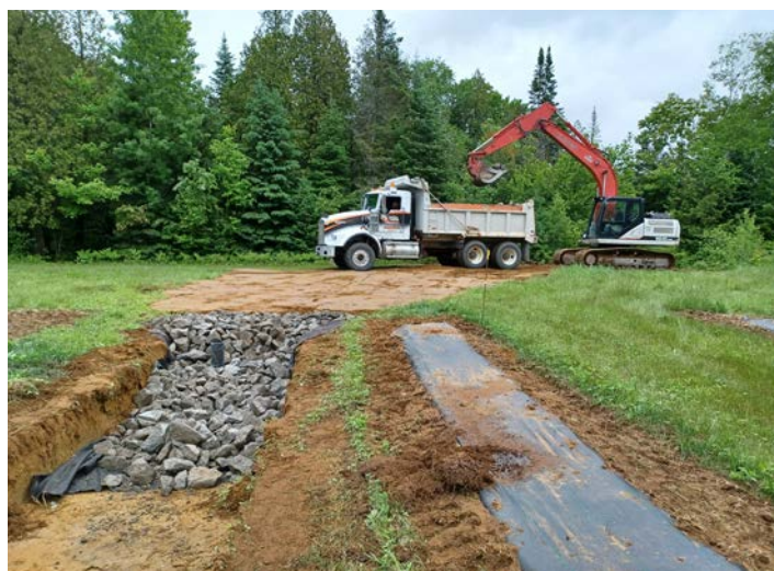
Figure 3.16 Aménagement d'un ponceau-avaloir. © MAPAQ Mauricie
