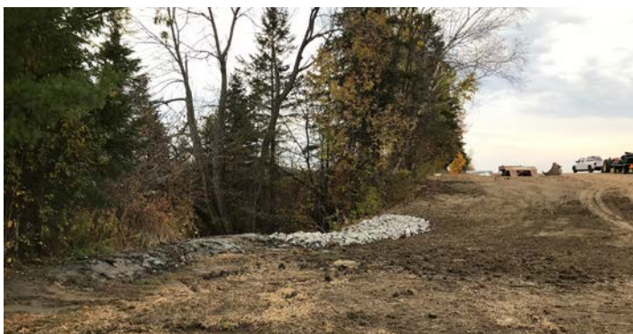
Figure 3.14 Aménagement d'une risberme dirigeant l'eau de surface vers un déversoir enroché. © MAPAQ Mauricie
