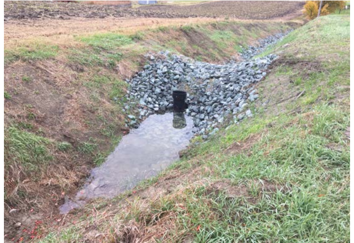
Figure 3.19 Seuil avec avaloir et fossé enroché © MAPAQ Centre-du-Québec
