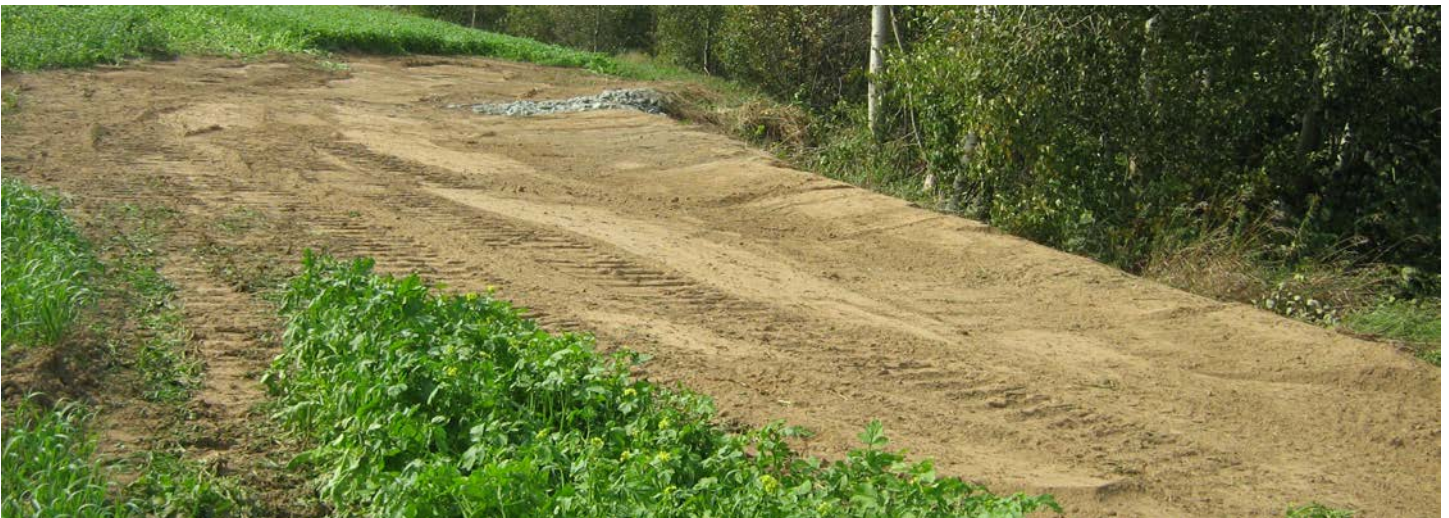
Figure 3.7 Travaux d'aménagement d'une risberme associée à un déversoir enroché qui, à terme, permet de limiter l'érosion et le transport de particules de sol vers les cours d'eau. © Hélène Bernard, MAPAQ Mauricie
