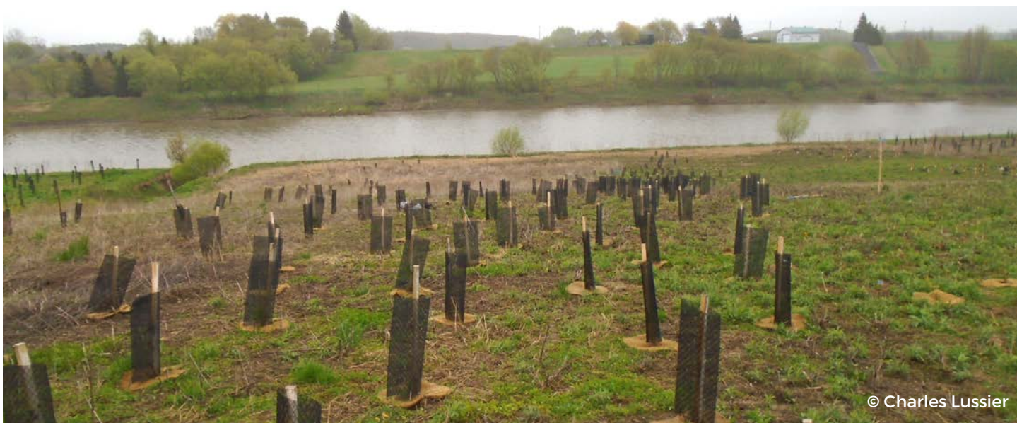
Figure 3.20 Berge reprofilée avec cornouiller stolonifère et pieux avec fascines de saules en pied de berge © Charles Lussier
