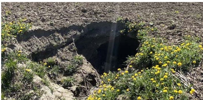
Figure 3.13 Bris du haut de talus par le ruissellement de surface provenant du champ. © MAPAQ Mauricie
