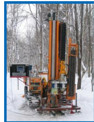
Un système de sondage utilisé sur le terrain
