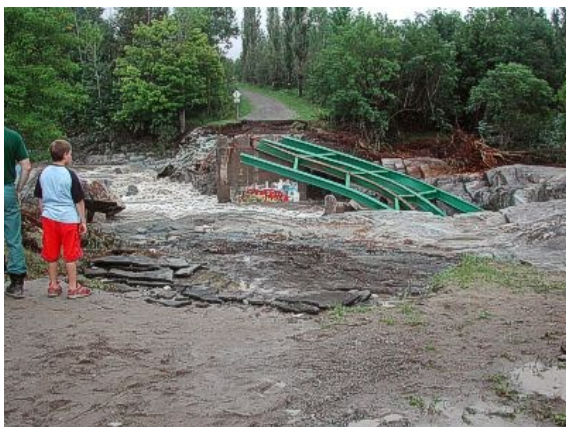
Route emportée à Tingwick suite aux fortes pluies du 3 août 2003
