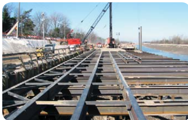
Après : Construction d'un nouveau mur d'amarrage à l'écluse 2 (canal Welland)
