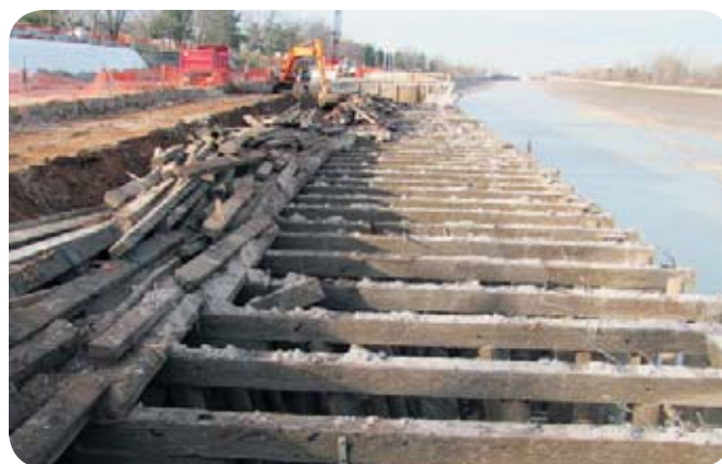
Avant : Enlèvement du mur d'amarrage à pilotis à l'écluse 2 (canal Welland)
